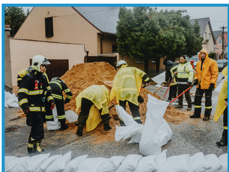
Preparación de los sacos de arena tradicionales.
