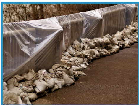
Mise en place des solutions traditionnelles
